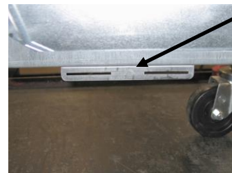
Рис. 1. Прикрепите юстировочный кронштейн к низу скобы блока автоматической подпиточной системы.
